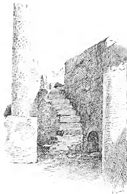
Escalier. (Région VII, Insula VI.)
